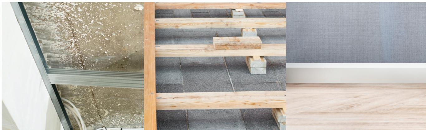
Быстрое сквозное крепление различных конструкций в материал основания. В том числе направляющих гипсокартона, плитусов, фанерного основания под паркетные полы, металлокаркаса.
